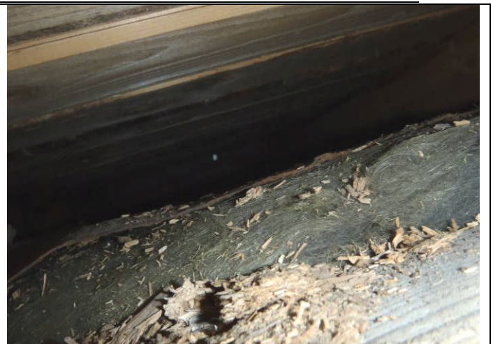
4. Yläpohjarakennetta ja tuuletusrakoa avatulla kohdalla
