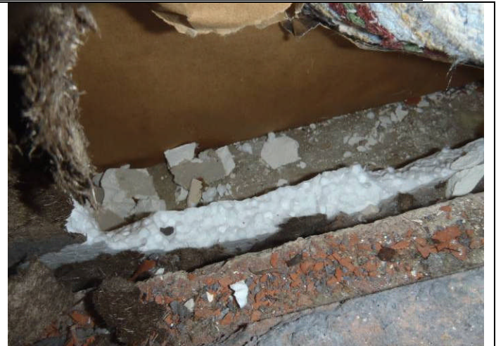
6. Ulkoseinän rakenteita pesuhuoneen kohdalla
