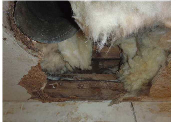
2. Avattu yläpohjarakenne vaatehuoneessa
