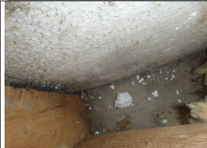
5. Ulkoseinän rakenteita olohuoneen kohdalla
