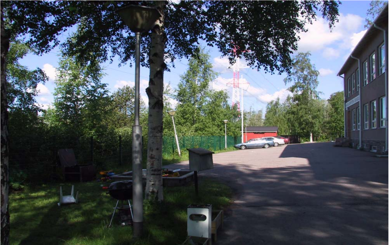
KUVA 26. Vinossa oleva pylväsvalaisin.
