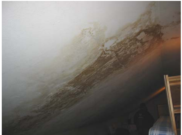
KUVA 16: Lämpöeristetyin käyttöullakon katossa vanhoja kosteusvauriojälkiä.
