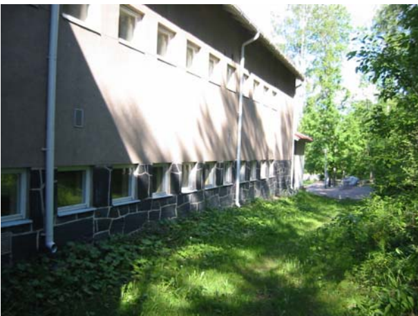
KUVA 3: Kuva rakennuksen itäsivustalta.
