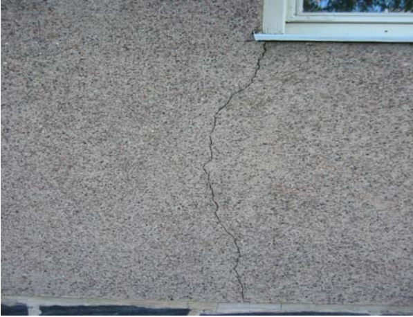
KUVAT 7 ja 8: Rakennuksen eteläpäädyn rakenteissa esiintyi halkeamia mitkä viittaavat perusrakenteiden painumiseen.
