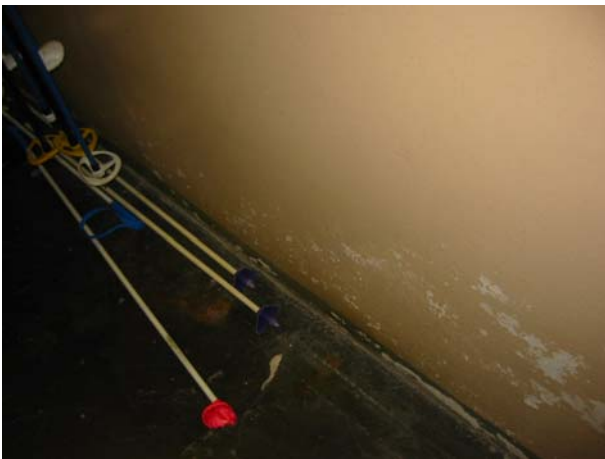
KUVAT 9 ja 10: Maaperää vasten olevissa rakenteissa esiintyi merkkejä rakenteeseen pääsevistä kosteudesta. Kellariluokan lattia puurakenteinen ja sen kunto syytä selvittää.
