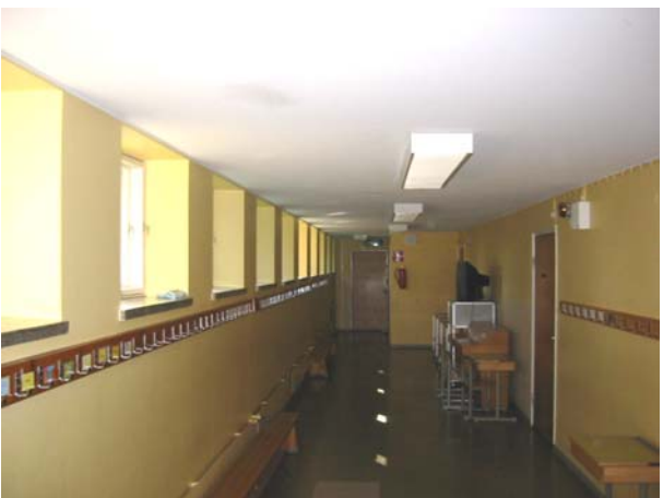
KUVAT 17 ja 18: Yleiskuvat käytävästä ja luokkatilasta.
