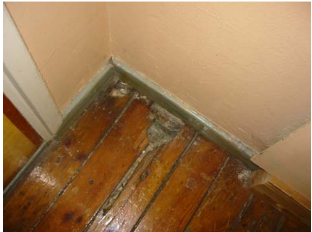
KUVAT 9 ja 10: Maaperää vasten olevissa rakenteissa esiintyi merkkejä rakenteeseen pääsevistä kosteudesta. Kellariluokan lattia puurakenteinen ja sen kunto syytä selvittää.
