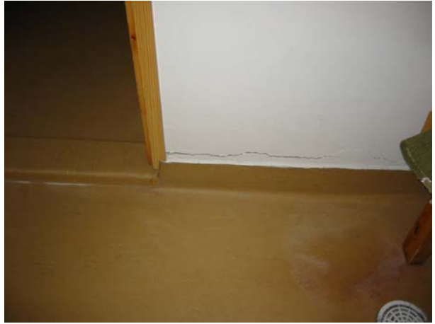
KUVAT 7 ja 8: Rakennuksen eteläpäädyn rakenteissa esiintyi halkeamia mitkä viittaavat perusrakenteiden painumiseen.
