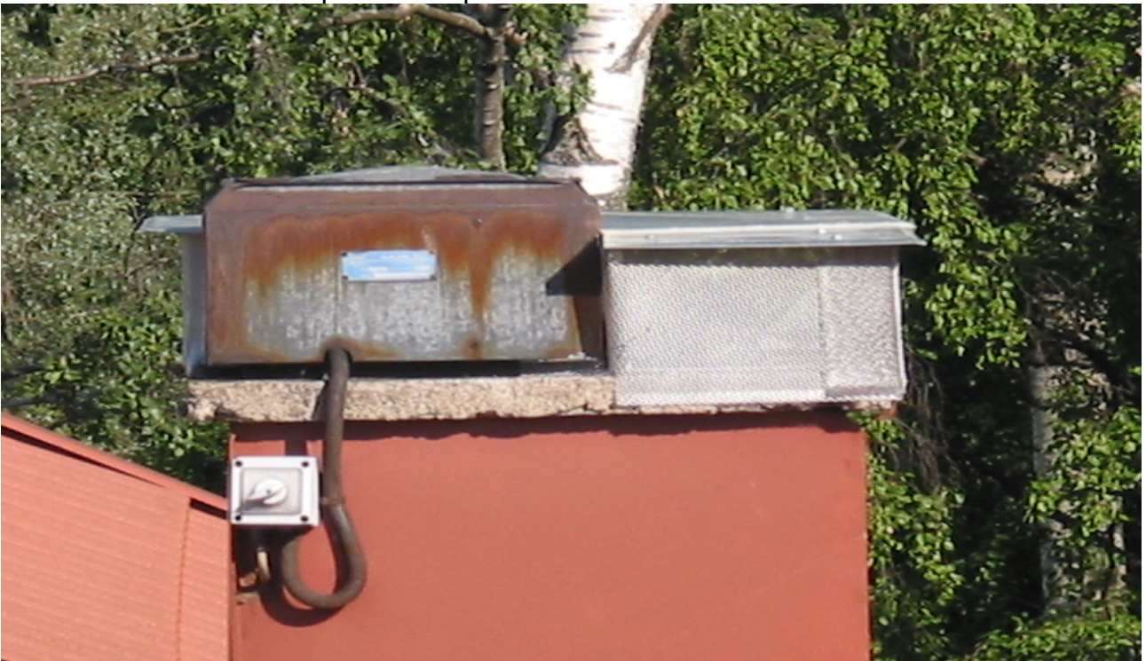
KUVA 25. Ruostunut huippuimuri.
