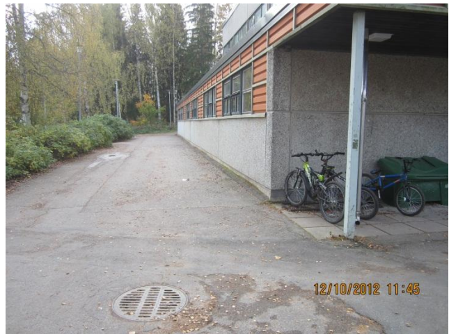
kuva 2 Kentän puoleisen pihan pintakallistukset ovat kunnossa.
