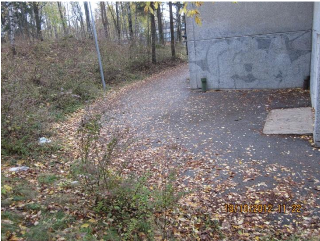
kuva 22 Yläpihalla sadevesi saattaa valua kohti liikuntasalin sisäänkäyntiä.
