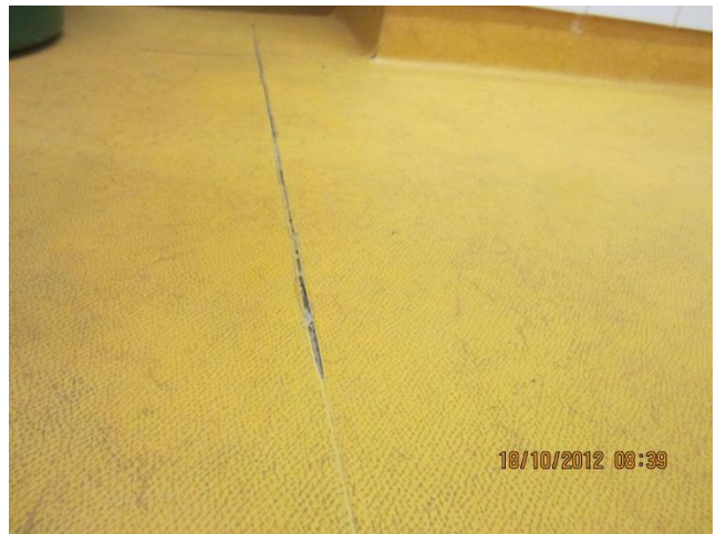
kuva 10 Ravistelutilassa 016 on muovimaton sauma revennyt.
