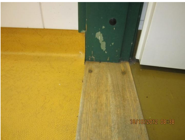
kuva 28 Pukuhuoneen 015 ja ravistelutilan 016 välinen kynnyks on matala puulista.
