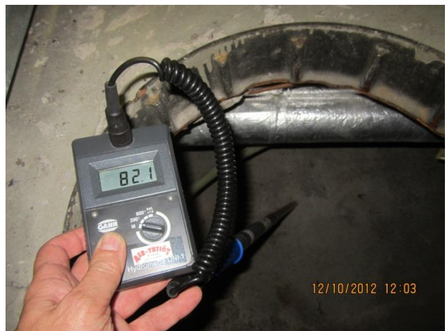
kuva 14 Putkikanaalin (LJH) pohjalta mitattiin pintakosteus, joka on normaalilla tasolla.
