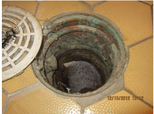
kuva 25 Aulan wc:n lattiakaivo.
