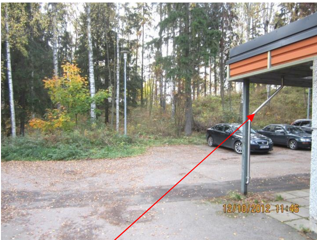
kuva 5 Syöksytorvet johtavat sadevedet alemmalla vesikatolta pihatasolle.
