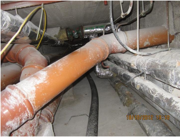
kuva 33 Hammashoitolan käytävän alla kulkeva putki- kanaali.
