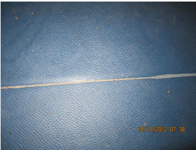
kuva 9 Ravistelutilassa 013 on muovimaton sauma revennyt.
