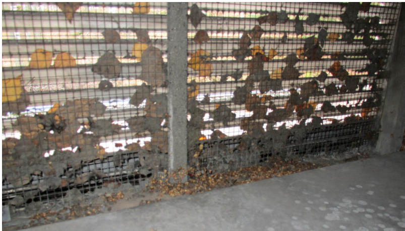
Kuva 2. Ulkoilmasäleikössä on koi- vunlehtiä.
