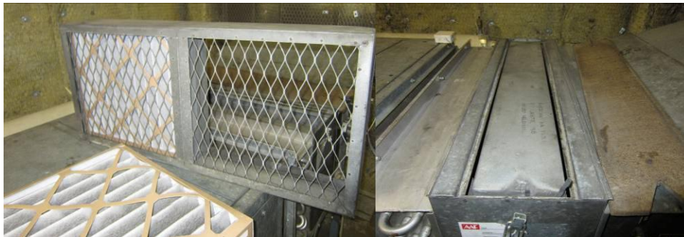
Kuvat 16-17. Tuloilman suodatinkehikon tiiveyttä on parannettu asentamalla tiiviste kehikkoon.
