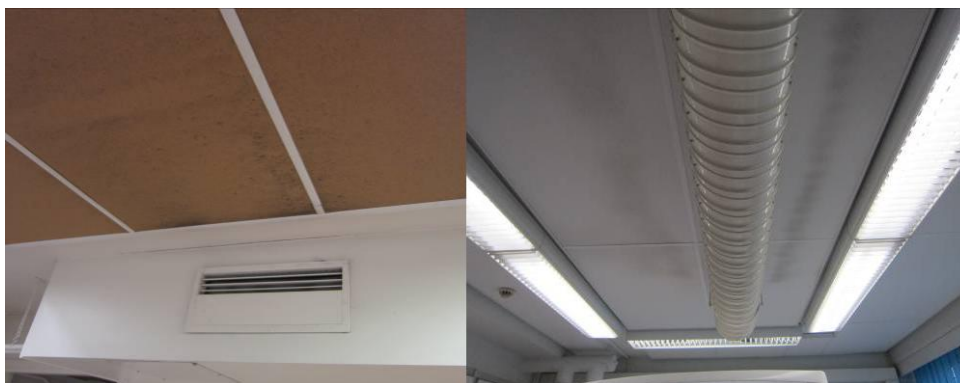
Kuvat 52-53. Akustolevyt ovat tummenneet.
