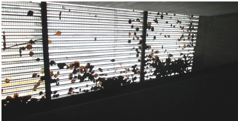
Kuva 25. Ulkoilmasäleikössä on koivunlehtiä.
