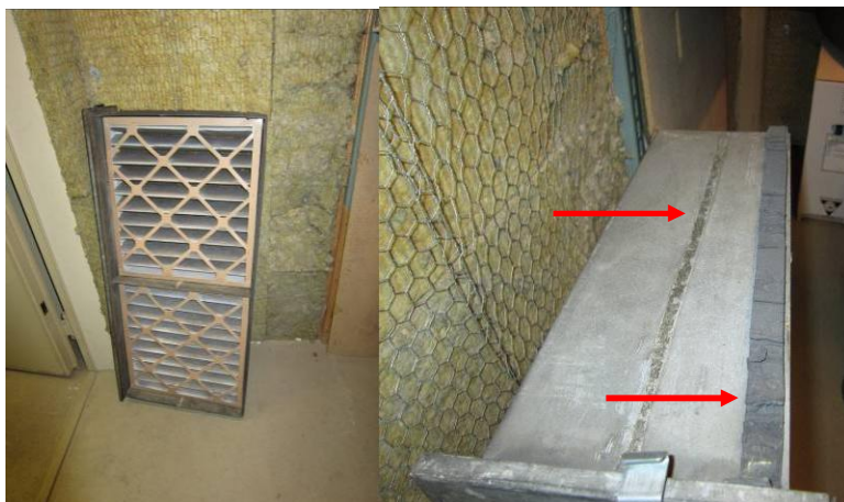
Kuvat 3-4. Tuloilman suodatinkehikon tiiveyttä on parannettu asentamalla tiiviste kehikkoon.
