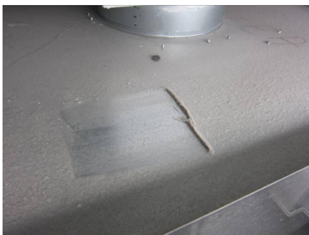
Kuva 51. Poistoilmakuvun päällä on melko paljon pölykertymää.
