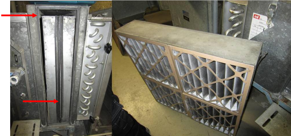
Kuvat 27-28. Tuloilman suodatinkehikon tiiveyttä on parannettu asentamalla tiivisteitä kehikkoon.
