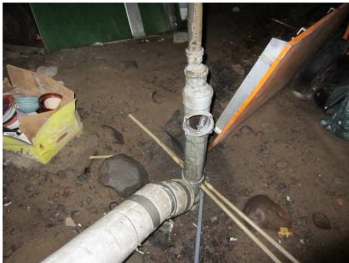
kuva 13 Katoksen syöksytorvi savunpoistoluukkujen vieressä. kuva 14 Sadevesiviemäri alustatilassa
