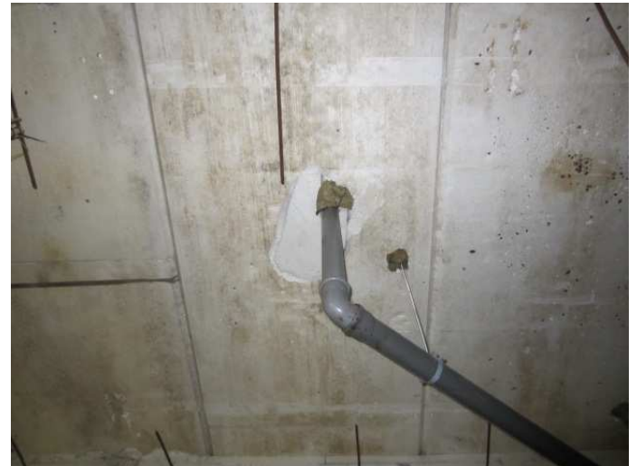
kuva 22 Viemärihajotukset. kuva 23 Viemäriputkien läpiviennit on tiivistetty paikoin villalla
