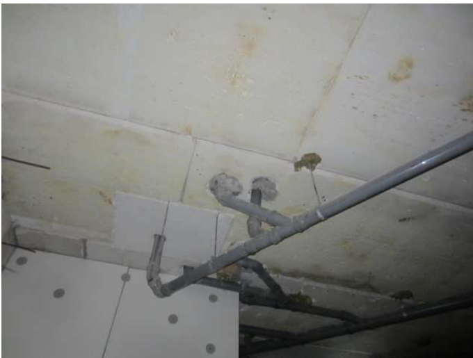
kuva 22 Viemärihajotukset. kuva 23 Viemäriputkien läpiviennit on tiivistetty paikoin villalla
