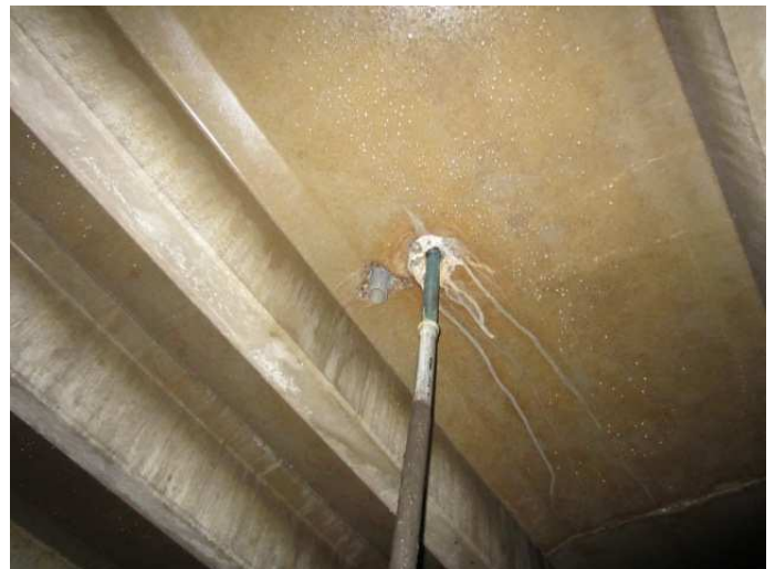
kuva 13 Katoksen syöksytorvi savunpoistoluukkujen vieressä. kuva 14 Sadevesiviemäri alustatilassa
