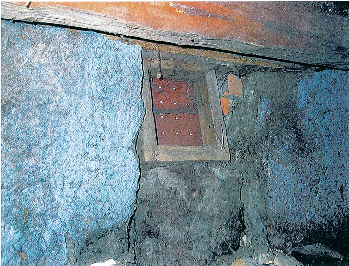
KIVIMUURISSA ON PUISIA TUULETUSLUUKKUJA, KUVA 2.
