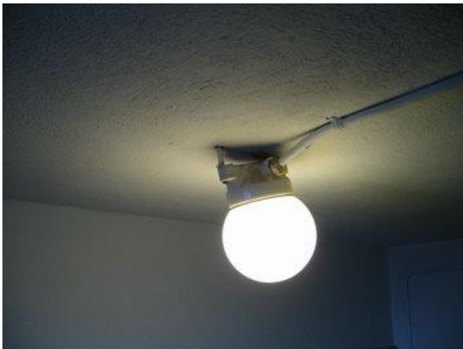
Valaisin on irronnut kiinnityksestään.
