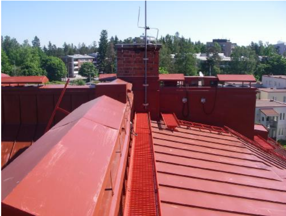
Kivikoulun vesikatolla on runsaasti käyttöikää jäljellä.
