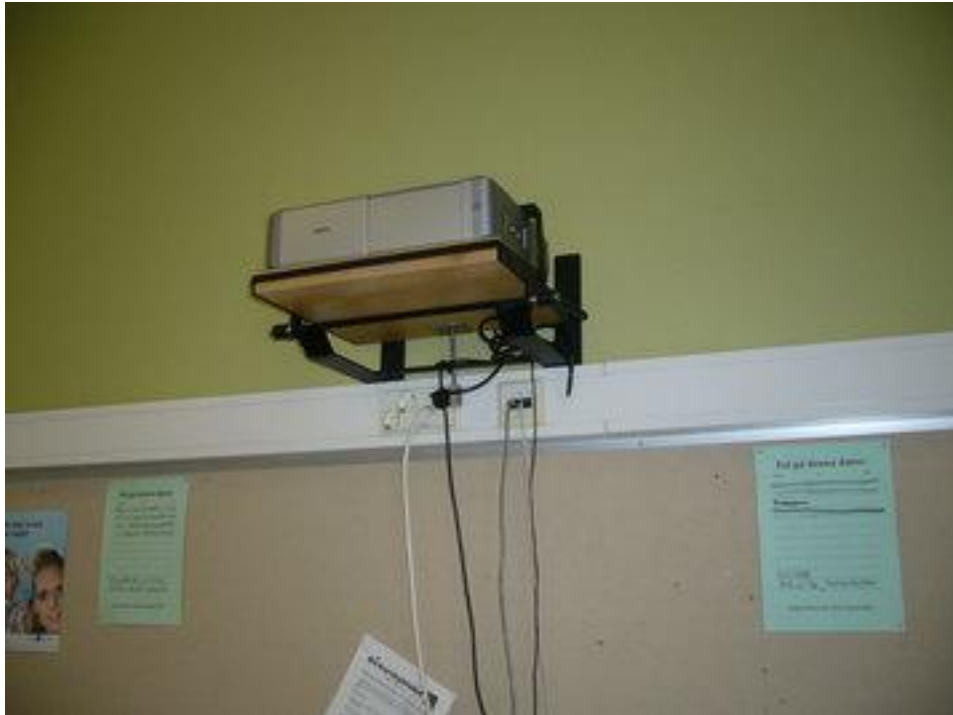
Atk-luokkaan on asennettu muoviset johtokanavat.
