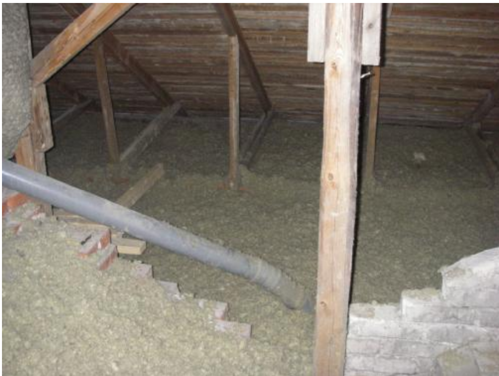
Kivikoulun yläpohjan eristeeksi on asennettu puhallusvilla.
