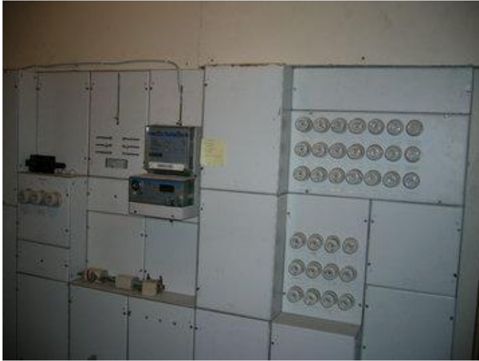
Kiinteistön sähköpääkeskus.
