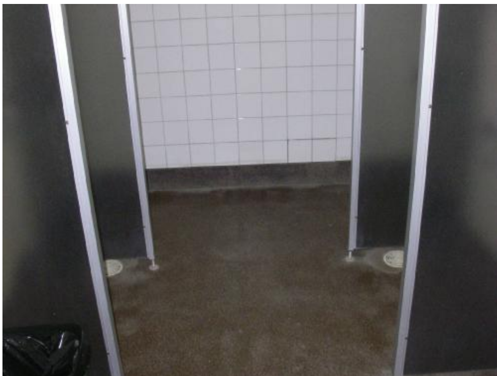
Suihkutilojen rakenteissa ei havaittu korjaustarpeita.
