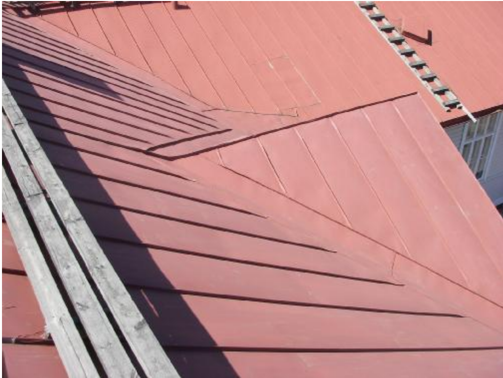
Näkymä puukoulun vesikatolta.
