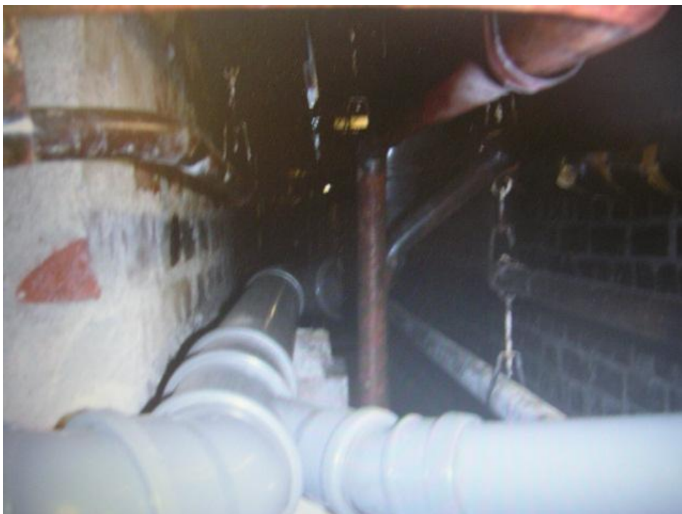
Näkymä päärakennuksen putkitunneliin.
