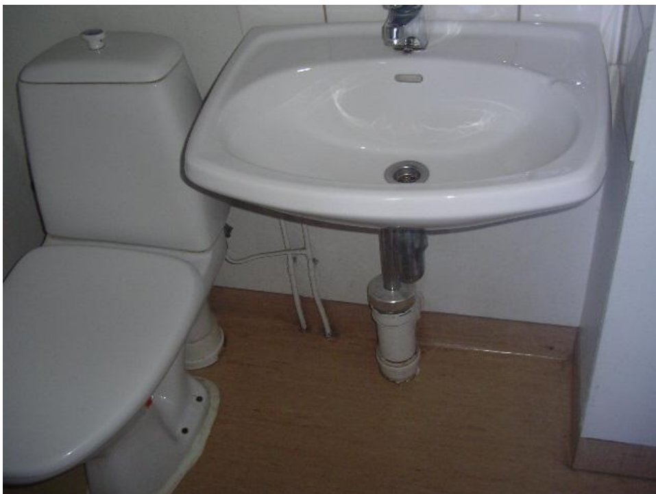
Päärakennuksen vesi- ja viemärikalusteet olivat tyydyttävässä kunnossa.
