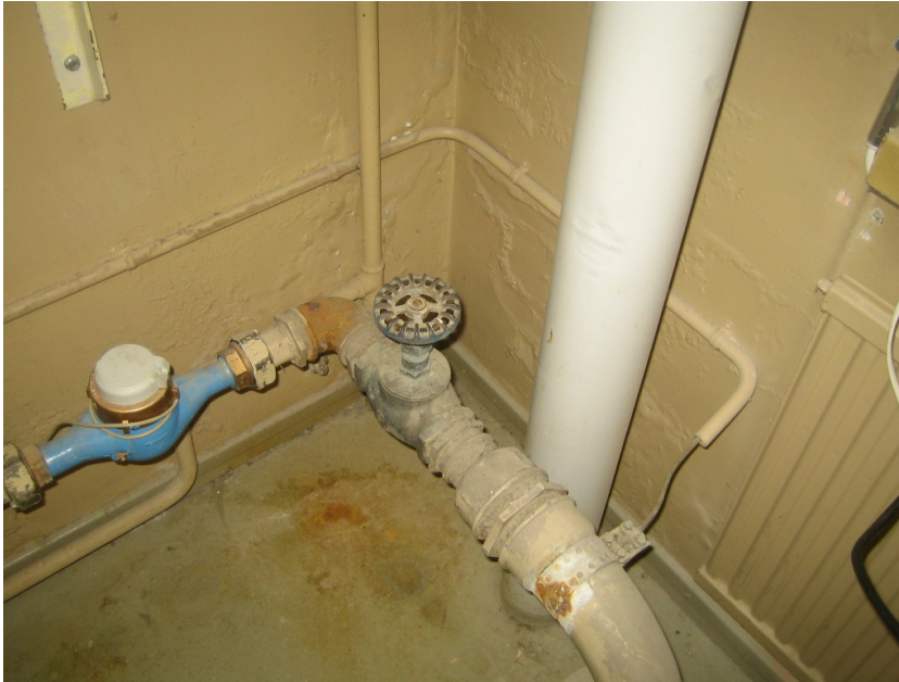
Kuva 9. Puutyöluokan maalatun betonilattia-alueen nurkassa on seinien maalipinnassa kupruilua.
