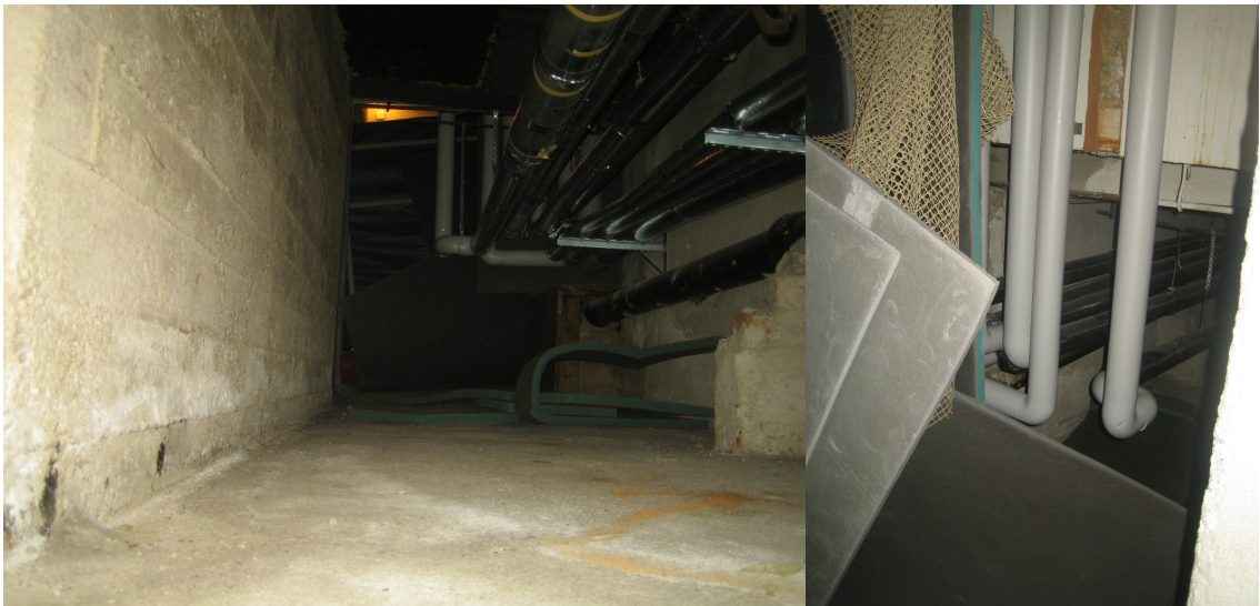
Kuvat 14 ja 15. Putkikanaalin liikuntasalin puoleinen pää on avonainen ja yhteydessä liikuntasalin patjavarastona toimivaan tilaan.
