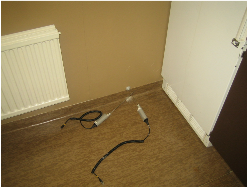
Kuva 4. Esimerkkinä ruokailu- ja lepohuoneen 043 seinän lisälämmöneristeen lyhytkestoisen suhteellisen kosteuden mittauksesta (mittapiste S1), jossa Vaisala Oy:n valmistama HMP42 kosteus- ja lämpötilamittapää on tiivistetty sisäverhouslevytyksen pintaan.
