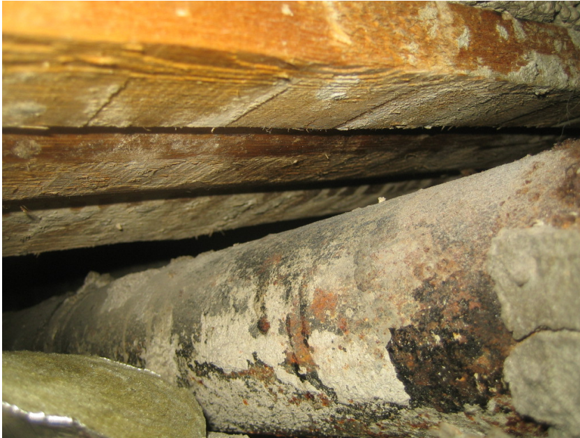
Kuva 13. Putkikanaalista on putkiläpivientejä sisäpihan puoleiselle osalle, jossa on muotti-puttavaraa nähtävissä.
