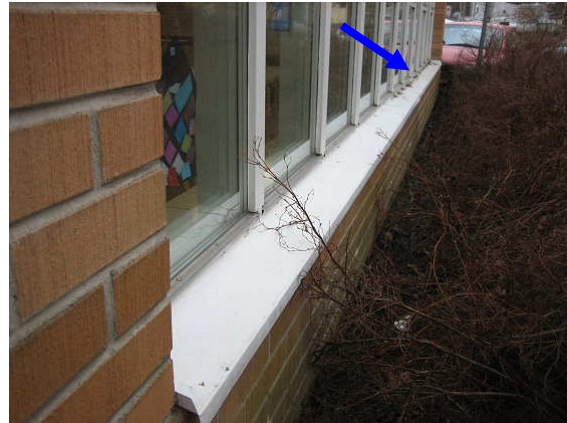
Kuva 12 Vesipelti kiertää rakennukseen päin keittiön puoleisella osalla. Rakennuksen vierustalla on multamaata.
