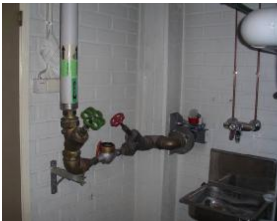
Kiinteistön vesimittari.
