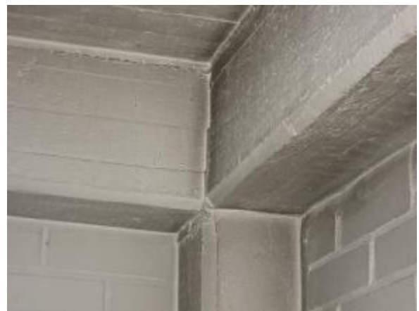
Teräsbetonisissa runkorakenteissa ei havaittu huomautettavaa.
