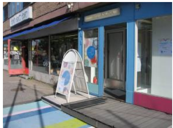
Liiketilöiden ikkunallisia teräsovia.
