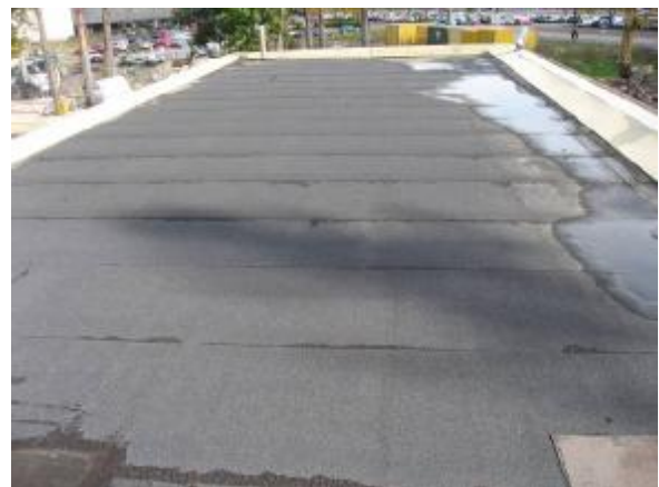
Laajennusosan kattoa. Katemateriaalina toimii sirotepintainen bitumikermikate.
