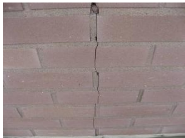
Pystyhalkeama rakennuksen länsijulkisivulla.
