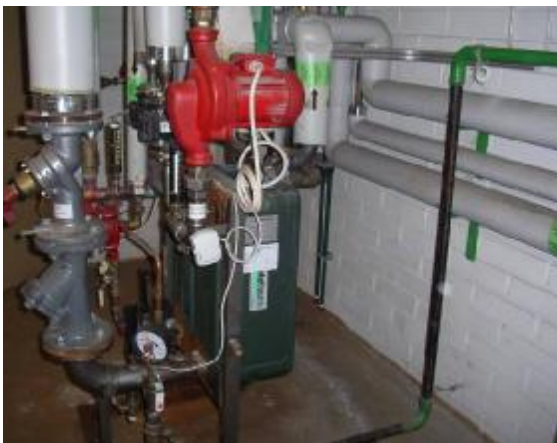
Lämmönjakokeskuspaketti.
