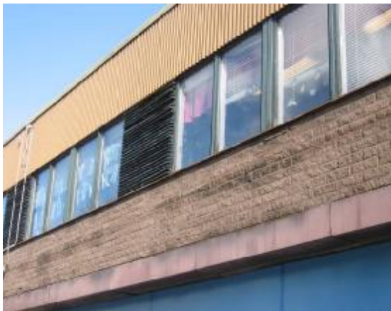
Asematien puolella seinäpinnat olivat mm. tiili- ja peltipintaisia.
