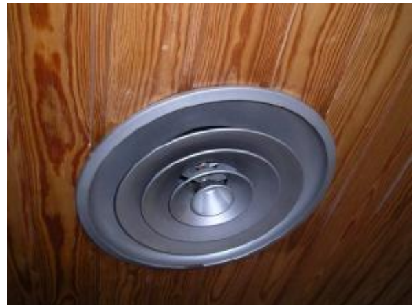
Päätelaitteet ja kanavavarusteet olivat vanhoja.
