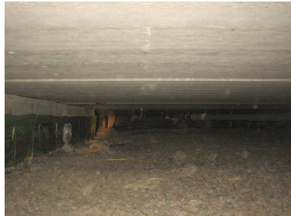
Kuva 10 A-osan alustatila on matala. Pinnalla on laudankappaleita yms..
