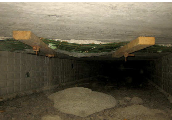
Kuva 5 A- ja B-osien liitosvalun tukipuut ovat jäljellä.
