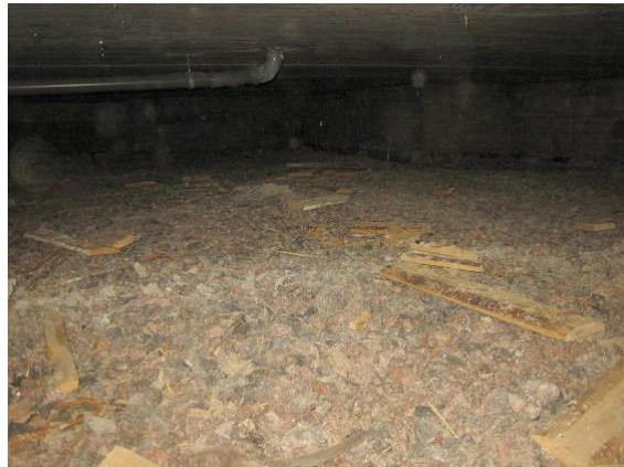
Kuva 4 Alustatilassa on laudankappaleita ja sahanpurua.
