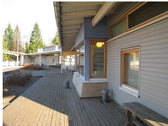
Kuva 18 Lännen/ luoteen puoleisilla sivustoilla on puurakenteita.
