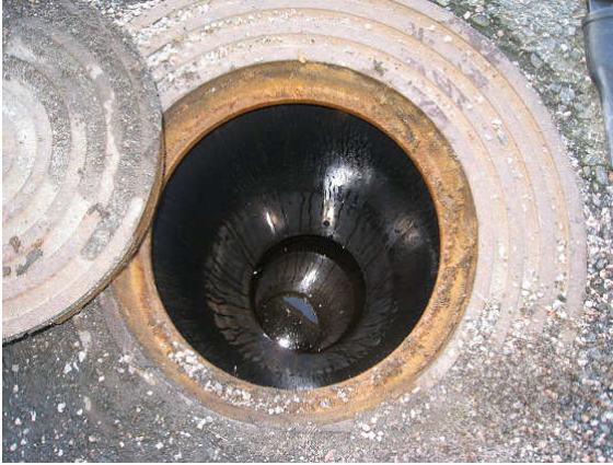
Kuva 19 Salaojaputkien tarkastuskaivo A-osan länsisivulla. Vesipinta on juoksupinnan tasolla.
