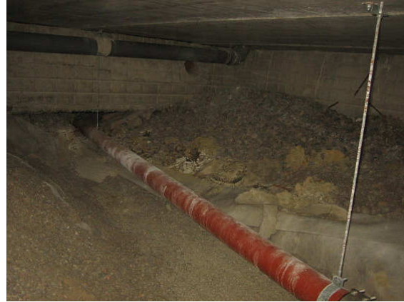
Kuva 14 Kuiva viemärikaivanto A-osan päädyn tuntumassa.
