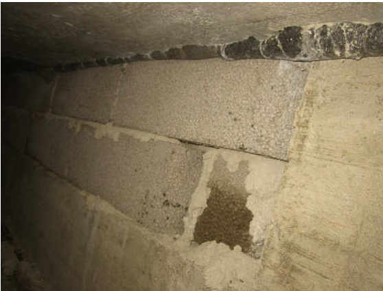
Kuva 3 Kevytsoraharkon ja ontelolaatan yh- tymäkohdassa on solukumiitiivistys.
