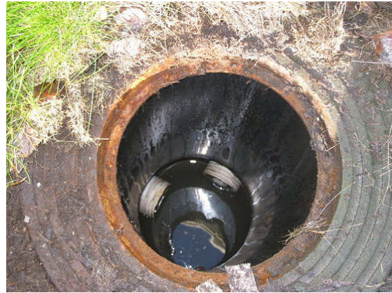
Kuva 16 Salaojaputkien tarkastuskaivo A-osan itäisivulla. Vesipinta on juoksupinnan tasolla.
