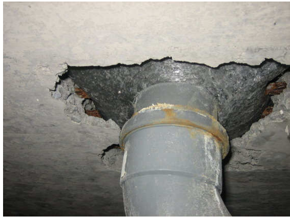
Kuva 22 Tyypillinen alustilan viemärläpivienti.
