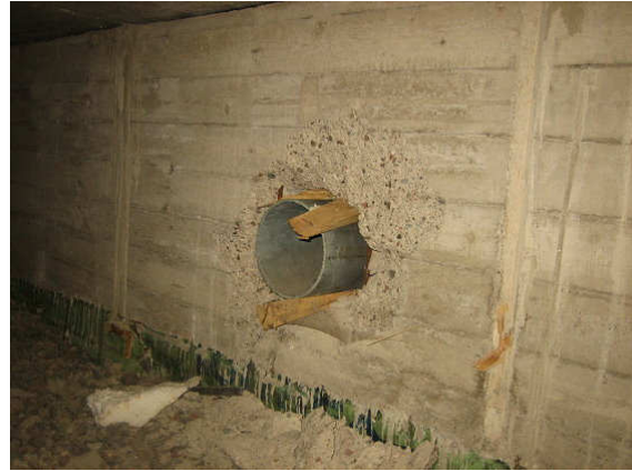
Kuva 2 Kahdessa perusmuurissa olevassa tuu- letusputkessa on kiilapuut poistamatta.
