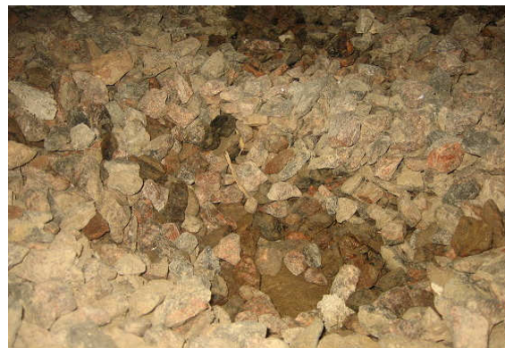
Kuva 6 Sepelitäyttö on märkää lähellä suoda- tinkangasta.
