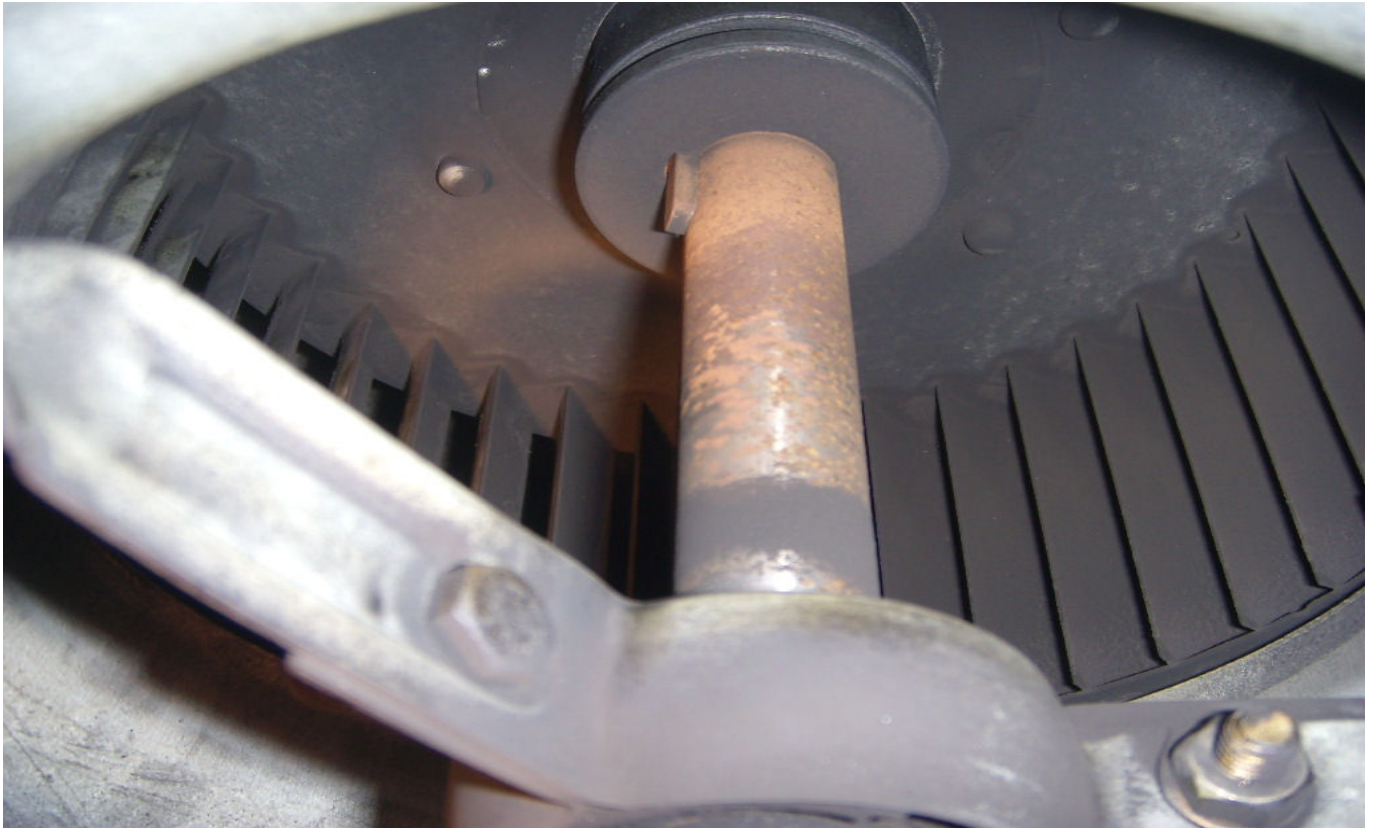
KUVA 5. Yleiskuva tuloilmapuhaltimesta TF 1.
